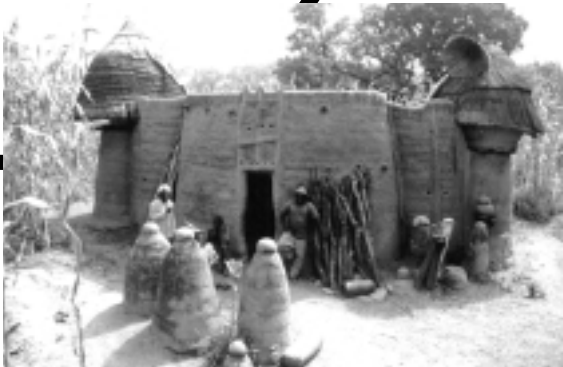
トーゴ(タンベルマ族の土の家)
